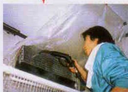
ジェット洗浄のスチームと熱湯パワーで、みるみるうちに汚れが除去されます
