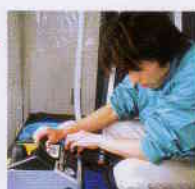
ジェット洗浄を行うためにスチームの圧力を慎重に調節します
